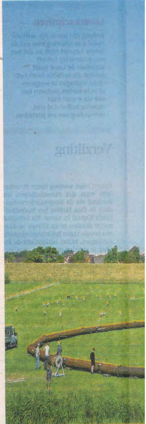
In een weiland langs de Waddendijk zet het team de installatie op.
